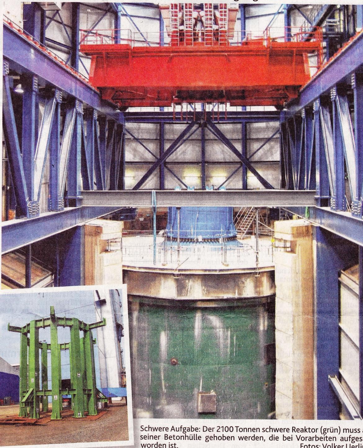
Schwere Aufgabe: Der 2100 Tonnen schwere Reaktor (grün) muss aus seiner Betonhülle gehoben werden, die bei Vorarbeiten aufgestellt worden ist.
