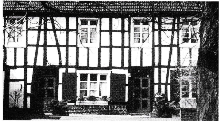
Tradition und modernste Technik: In diesem alten Fachwerkhaus wurden die Büroräume der Fa. CMS Sudhaus & Partner untergebracht.
